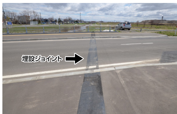
写真-4 路面状況(近接橋梁)
