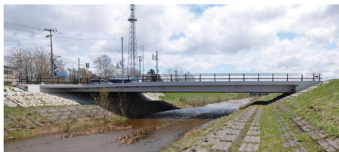
写真-1 雁来5号橋全景
