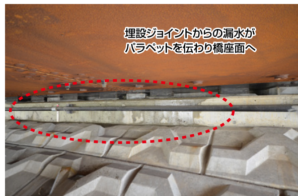
写真-5 桁下状況(近接橋梁)
