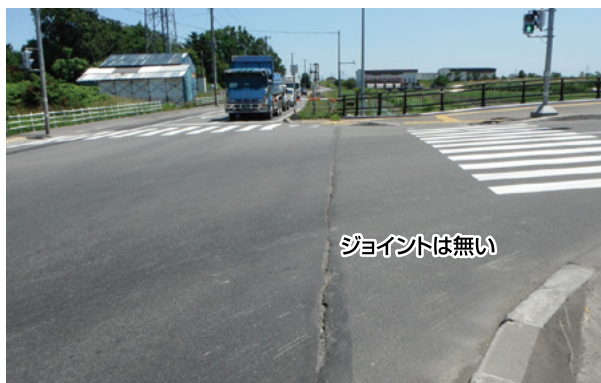
写真-2 路面状況(雁来5号橋)
