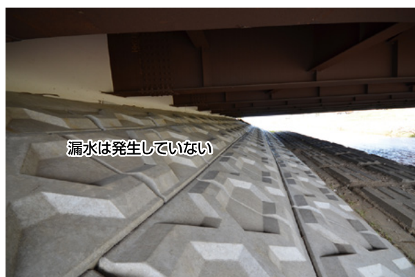
写真-3 桁下状況(雁来5号橋)
