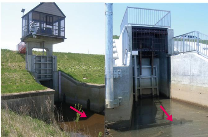
図-1 引き上げ式樋門(左)と自動開閉樋門(右)
