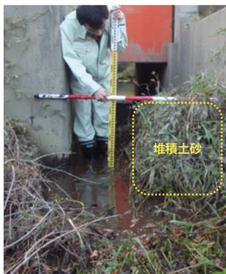
図-3 川表側土砂堆積
