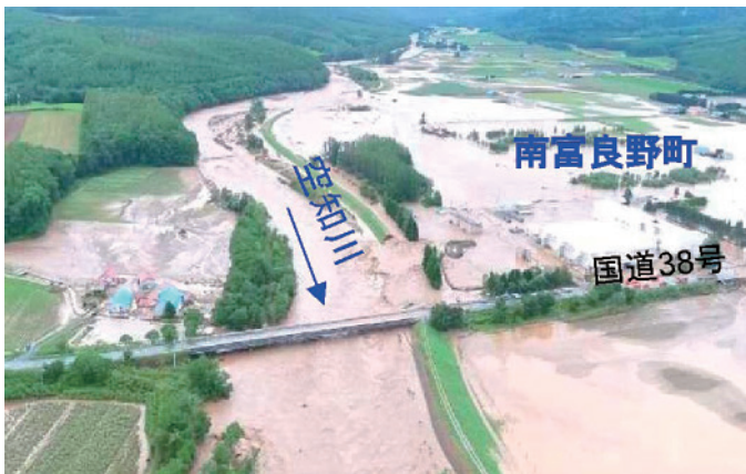
写真-1 空知川幾寅地区の氾濫状況 (国土交通省北海道開発局札幌開発建設部HP引用)
