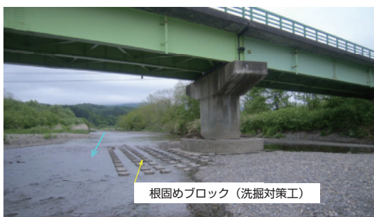
写真-2 竣工後橋脚状況 下流から橋脚を望む
