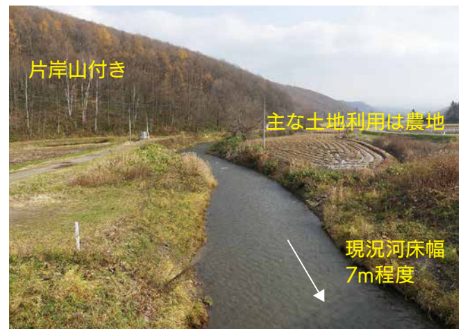
写真-1 現況河道状況
