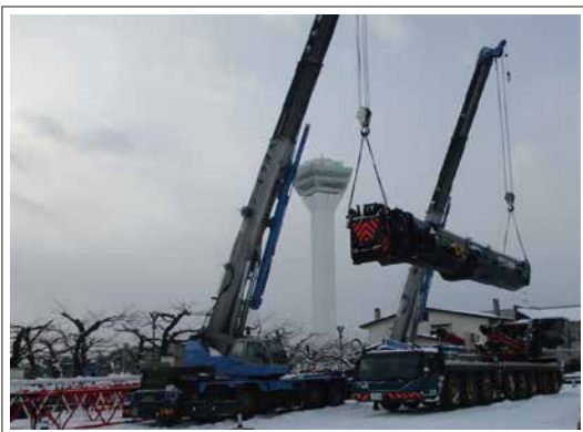
写真-7 クレーン組立(分解)状況
