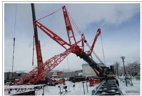
写真-8 ジブ組立(分解)状況
