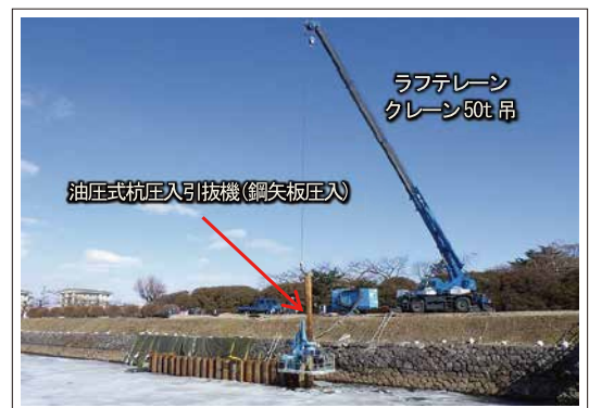
写真-3 鋼矢板による止水・施工状況
