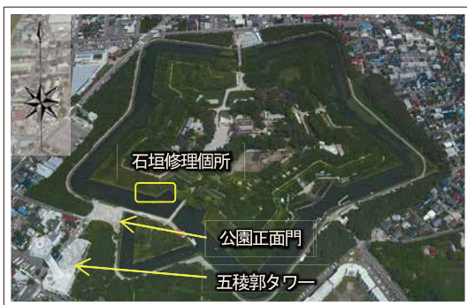
写真-1 石垣保存修理箇所
