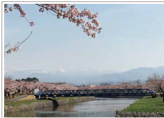
写真-10 桜並木と仮橋設置状況(5月)
