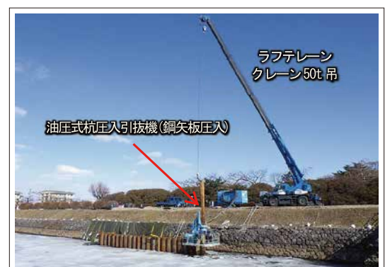
写真-3 鋼矢板による止水・施工状況
