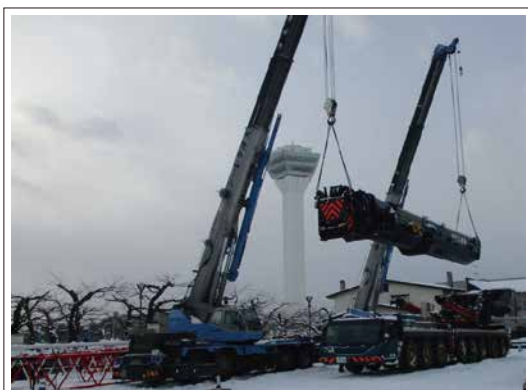
写真-7 クレーン組立(分解)状況
