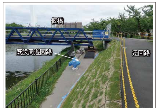
写真-6 仮橋設置状況
