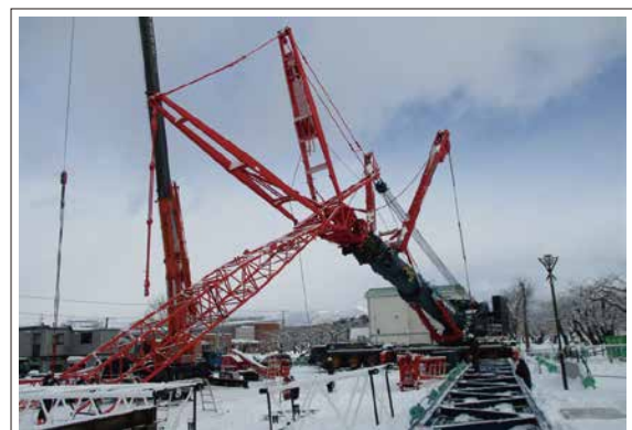
写真-8 ジブ組立(分解)状況
