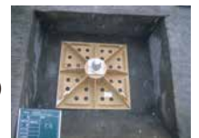
写真-4 グラウンドアンカーの設置状況(委託者提供)
