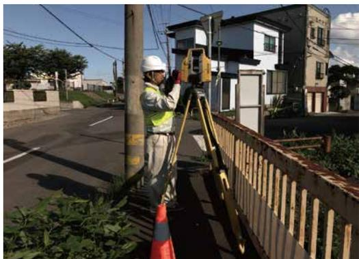
写真-2 地上レーザ計測
