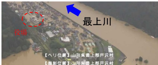
写真-1 中山間地域の浸水状況
