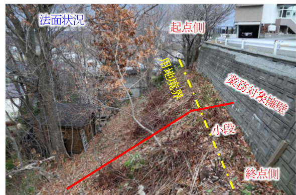
写真 1-2 法面及び擁壁状況
