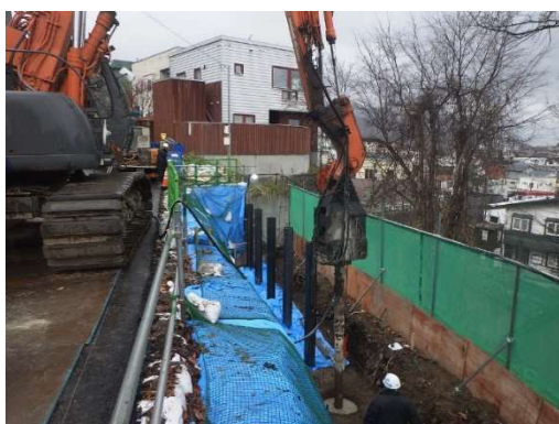
写真6-1 鋼管建込状況
